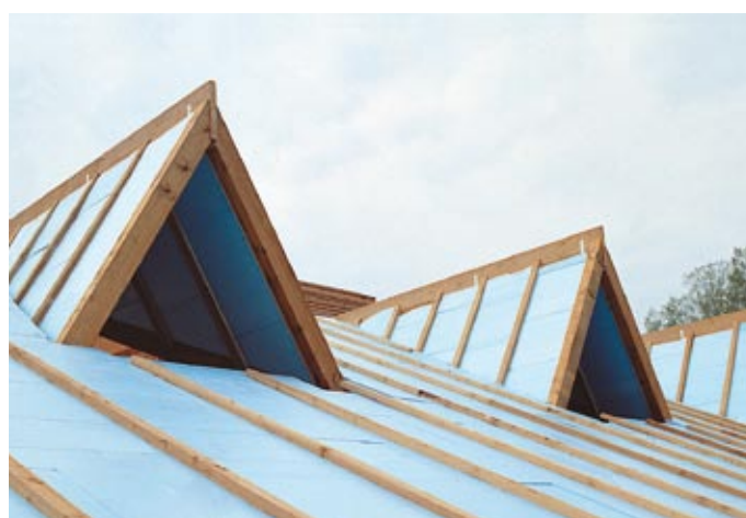
Applicazione della membrana VEMPRO
