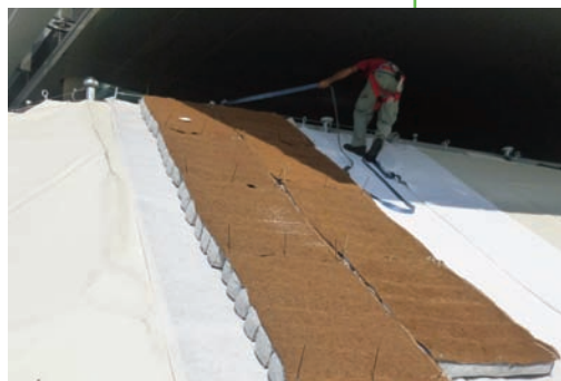
Fissaggio al colmo con golfari e cavo d'acciaio
